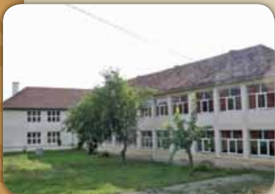
A felújított iskola
